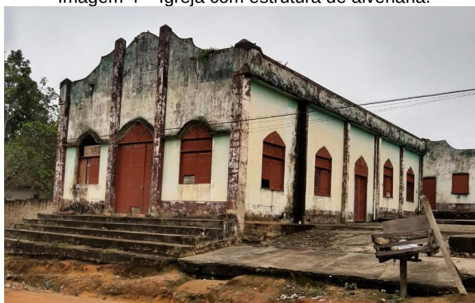
Imagem 4 – Igreja com estrutura de alvenaria.
