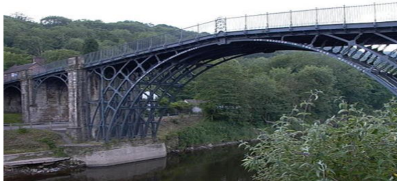
Figura 3 – Ironbridge, Shropshire, Grã-Bretanha. Fonte: Khouri e Serapião (2015).
