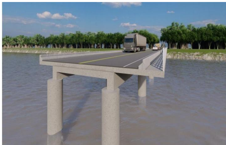
Figura 27- Ponte rodoviária em concreto armado com vão único. Fonte: Almeida,2026
