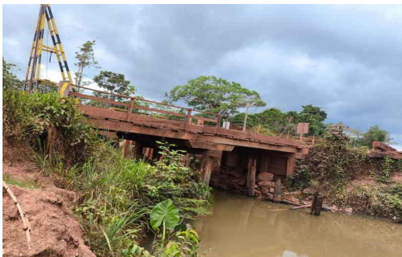
Figura 19 - Ponte KM7 município de Itaituba. Fonte: Almeida, (2025)
