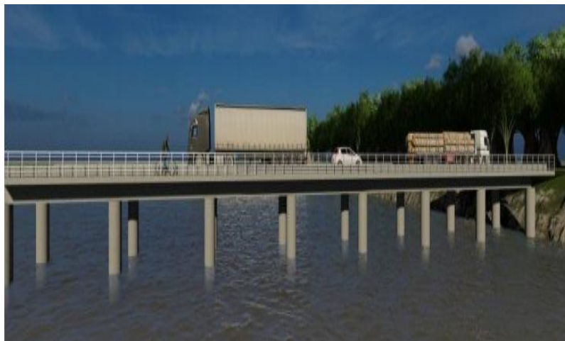
Figura 28- Vista ponte rodoviária em concreto armado. Fonte: Almeida, 2026
