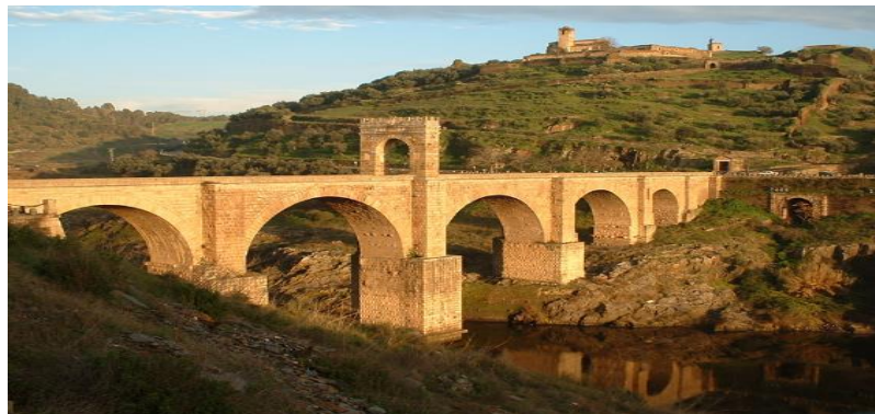
Figura 2 - Ponte de Alcântara, Alcântara, Espanha. Fonte: Khouri e Serapião (2015)
