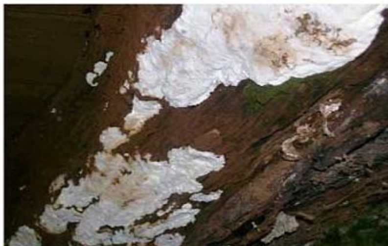
Figura 15 - Ataque na madeira por bactérias e fungos. Fonte: Milani e Kripka (2012)
