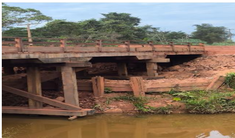
Figura 21 – Vista lateral e inferior da ponte de madeira Fonte: Almeida, (2025)
