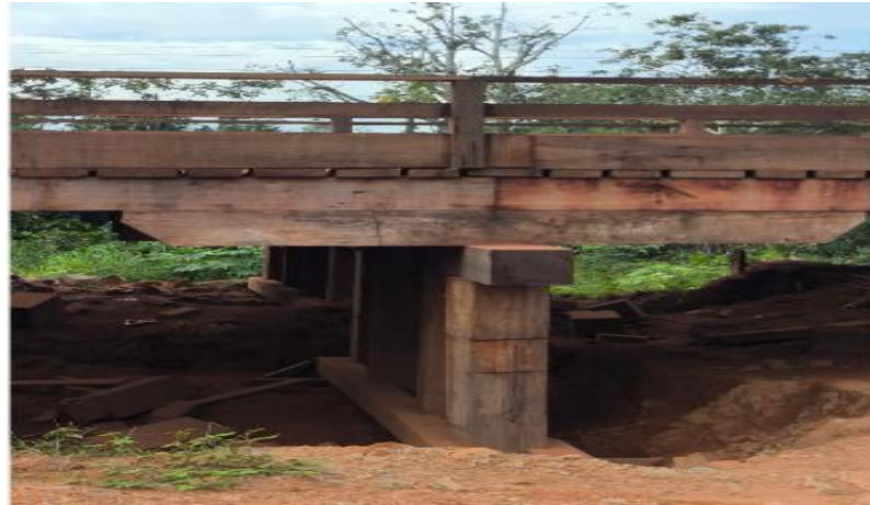
Figura 22 – Mesoestrutura da ponte de madeira, Fonte: Almeida, (2025)
