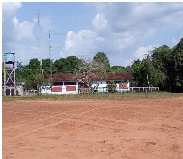
Acesso a EMEIEF “Nova Califórnia”.
